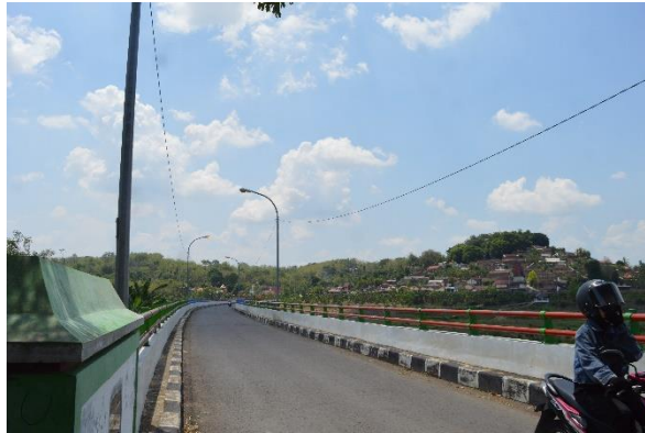
Gambar Jembatan Samudro
